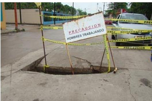
Figura 41. Hundimientos en calles de Balancán.
