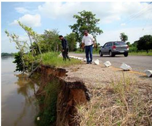
Figura 52. Carretera hacia capital del estado, destruida ante la erosión provocada por el río Usumacinta.
