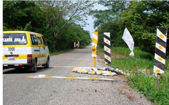
Figura 43. Hundimientos en carreteras debido a la acción del agua en Balancán.
