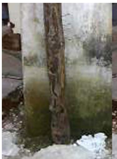
Figura 148. Marca de Profundidad de Inundación (0.65 mts.) en la parte más afectada de la Colonia San Marcos.
