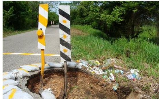
Figura 44. Diversos hundimientos en la ciudad de Balancán.
