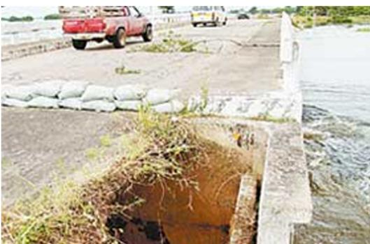
Figura 42. Hundimiento en el aproche del puente de la población Leona Vicario en Balancán.
